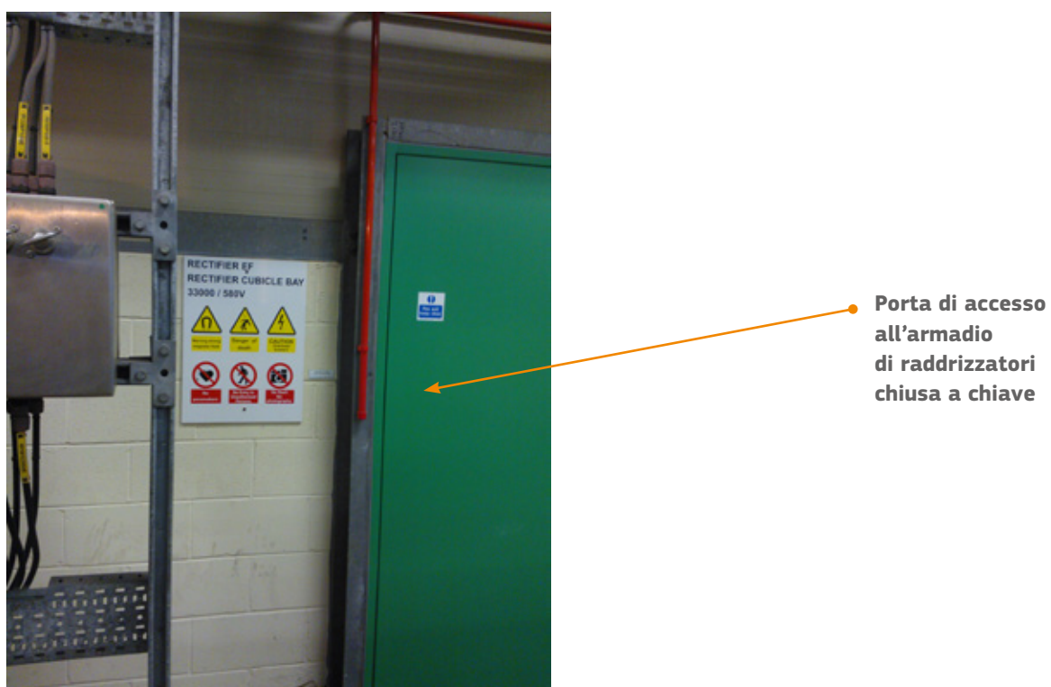
Figura 3.3 — Limitazione dell'accesso a una zona di armadi di raddrizzatori
